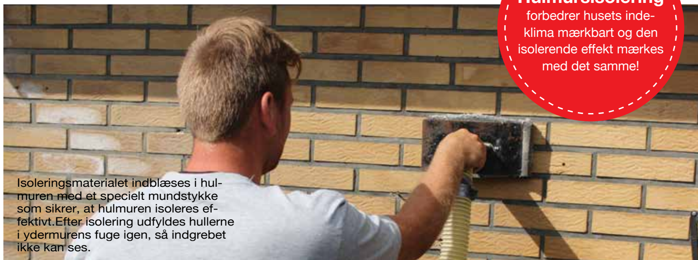
Hulmuren før efterisolering. Eksisterende isoleringsbatts falder sammen over tid og efterlader kuldebroer i hulmuren.
