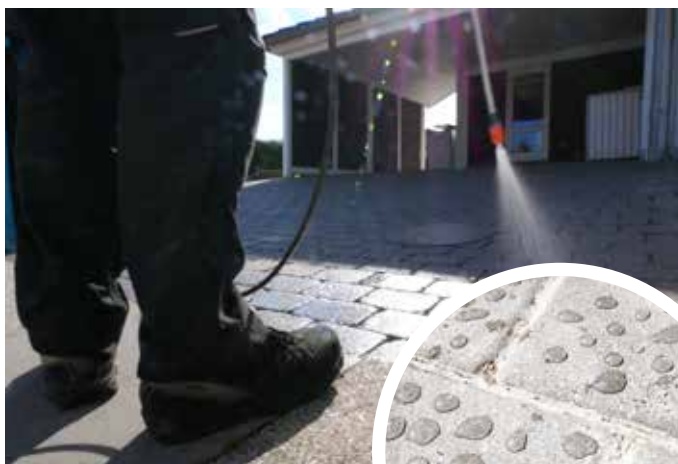
Imprægneringen har vandperleeffekt, hvormed fliserne bliver smuds- og vandafvisende.
